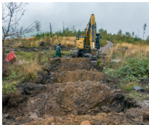
Obr. 3: Inovativní metoda jáma-hráz-jáma
